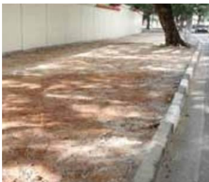
Figura 10 – Nivelamento e compactação do terreno
