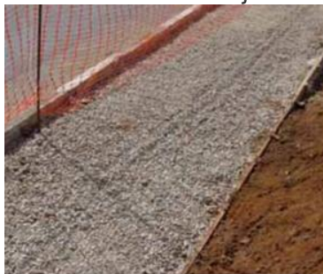
Figura 11 – Espalhamento da camada de Brita
