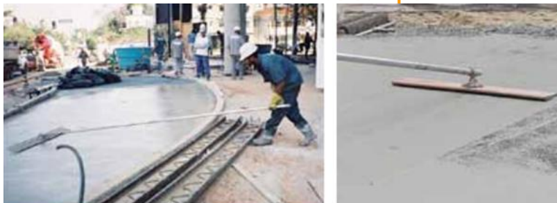
Figura 13 – Desempeno do concreto.
