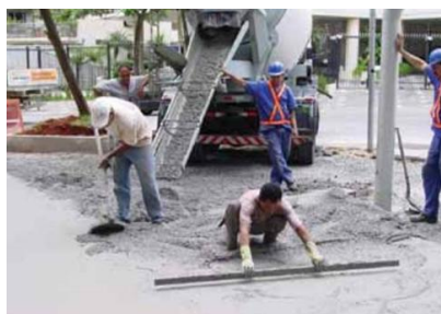
Figura 12 – Recebimento e espalhamento do concreto.
